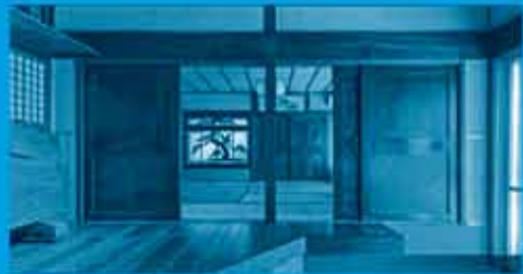
1階和室 古い重厚な建具は、松の何層の構造に漆喰で塗り固められた障子戸縁が美しい。
